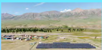
Автономные гибридные энергетические установки в сёлах Мугур-Аксы и Кызыл-Хая Республики Тыва (7 тыс. чел.). Суммарная мощность 550 кВт: СЭС и дизельные генераторы. Экономия топлива 30%.
