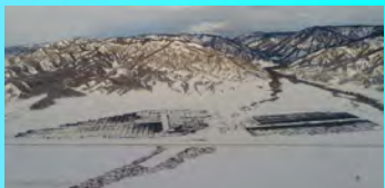
Усть-Коксинская СЭС (Республика Алтай). Мощность 40 МВт, площадь более 100 га, установлены 126 672 солнечных модуля.
