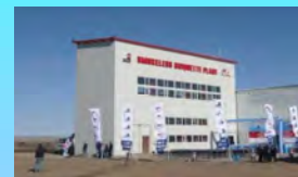
Первая фабрика бездымного топлива (Улан-Батор, 2008). Новый проект в Монголии: завод по производству брикетов бездымного топлива в объеме 210 тыс. т/год (построен – не запущен).
